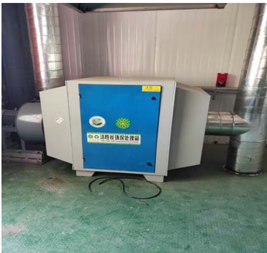
图 3-4 废气处理设备（活性炭吸附）及进出口管道
