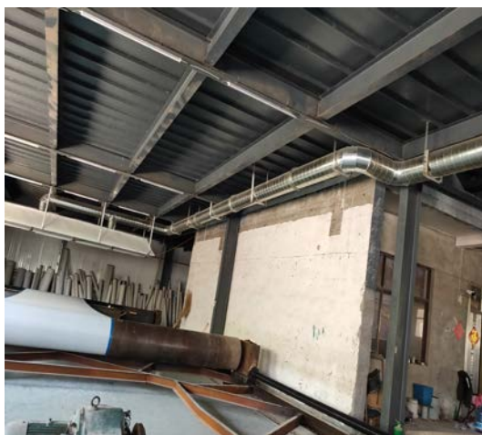
图 3-2 定型机集气罩及管道
