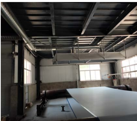
图 3-2 定型机集气罩及管道
