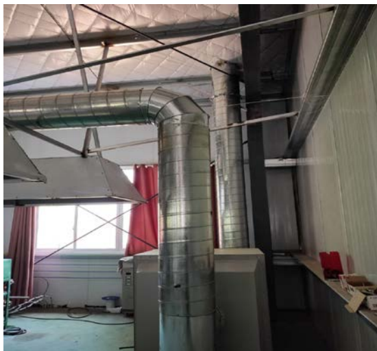
图 3-4 废气处理设备（活性炭吸附）及进出口管道
